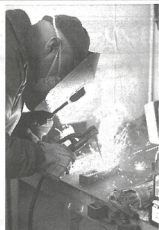
金型の修理の様子
